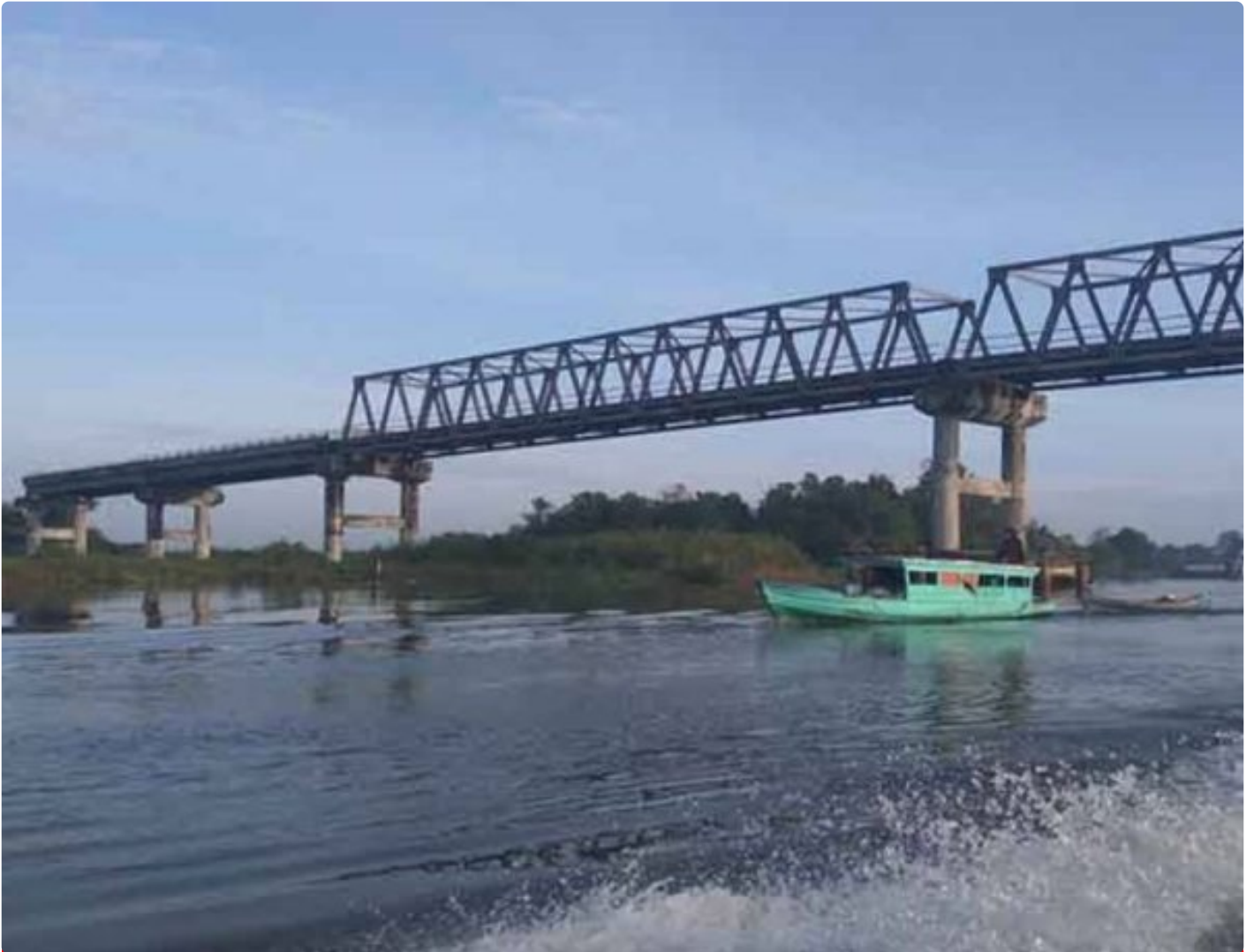
Jembatan Jelai di Kabupaten Sukamara
